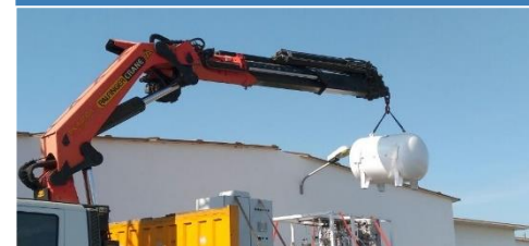
Almacenamiento de hidrógeno: tanque a presión e hidruros metálicos
