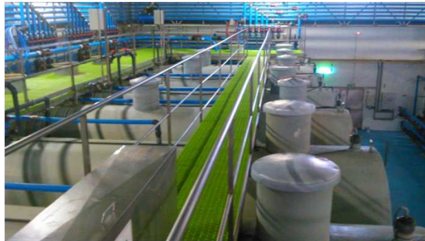
Tanques de proceso en industria agroalimentaria
