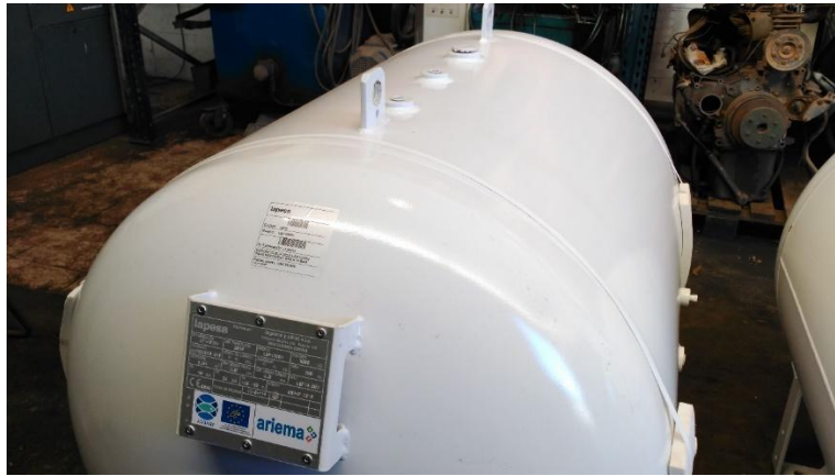
Imagen 3. Tanque presurizado para hidrógeno de 1m3 y presión nominal de 16bar adquirido para el proyecto.
