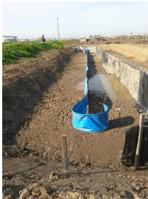
Ilustración 7. Detalle de la obra del tanque exterior
