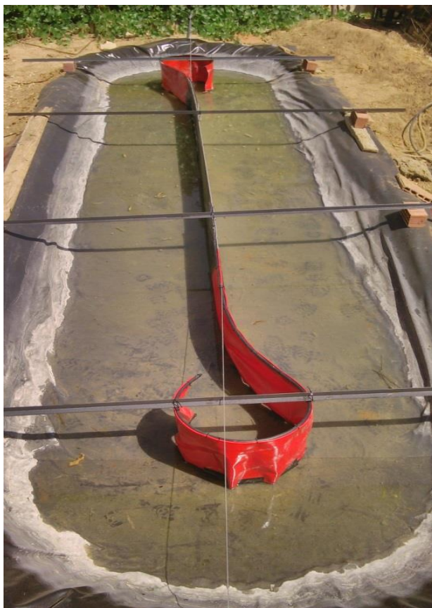
Ilustración 5. Tanque a escala construido previo a que el definitivo sea excavado en terrenos de la piscifactoría.
