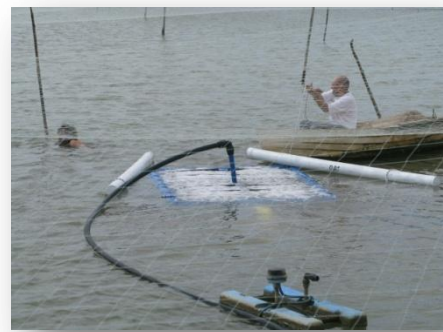
Imagen 1. Instalación parrilla O2Tech
