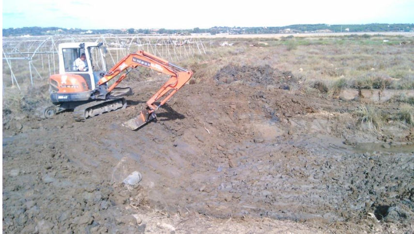
Ilustración 6. Obras de excavación del tanque exterior raceway
