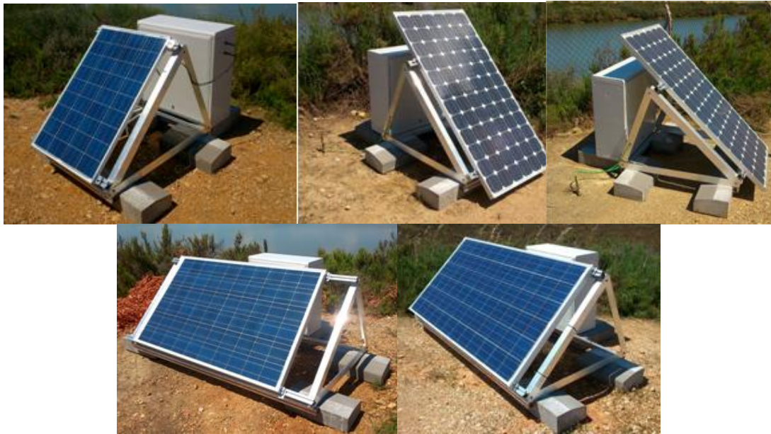
Imagen 1 a 5. Equipos Compactos Fotovoltaicos
